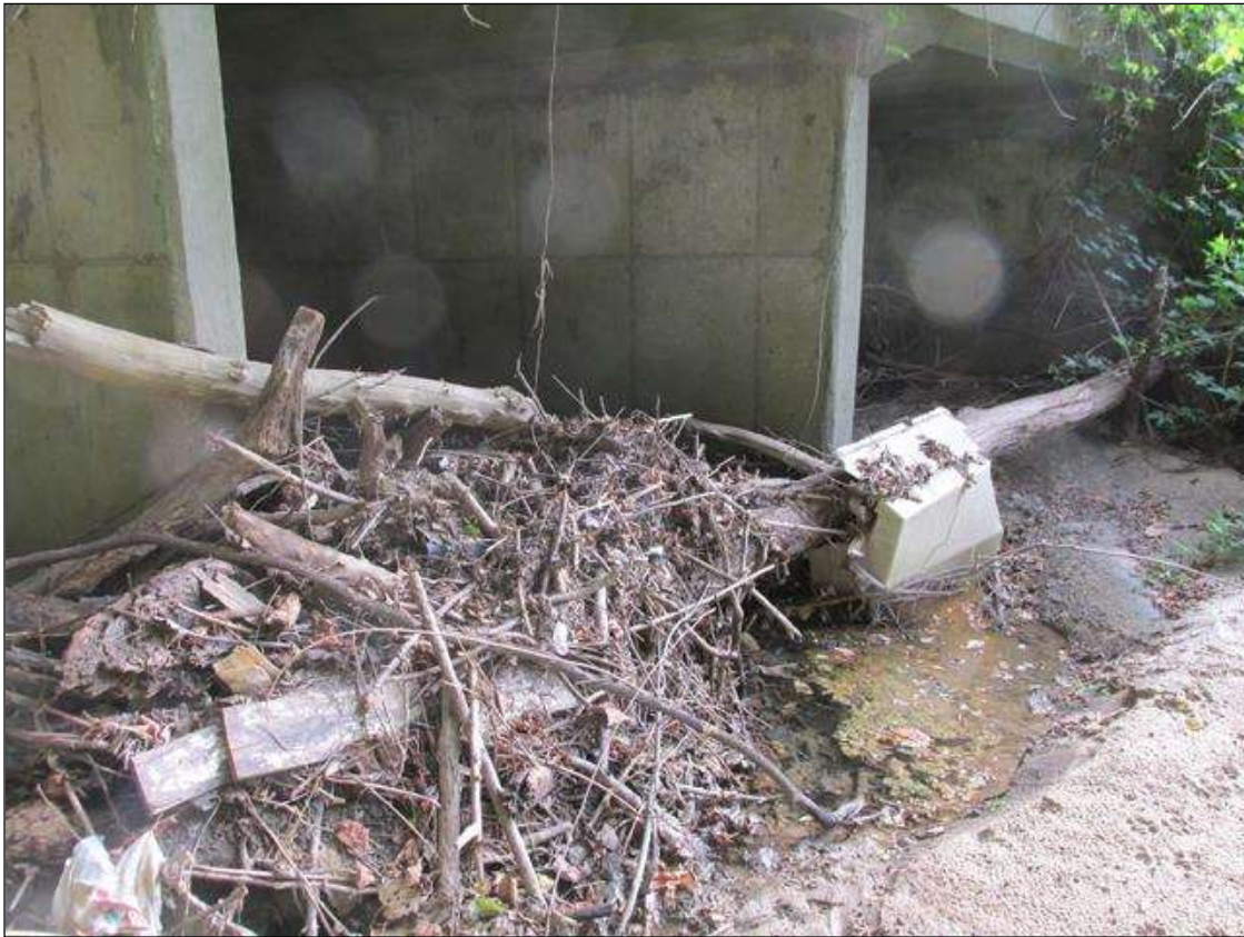
DRIFT ACROSS BARRELS 2&3, APPROX 14'L X 3'H X 3'W
